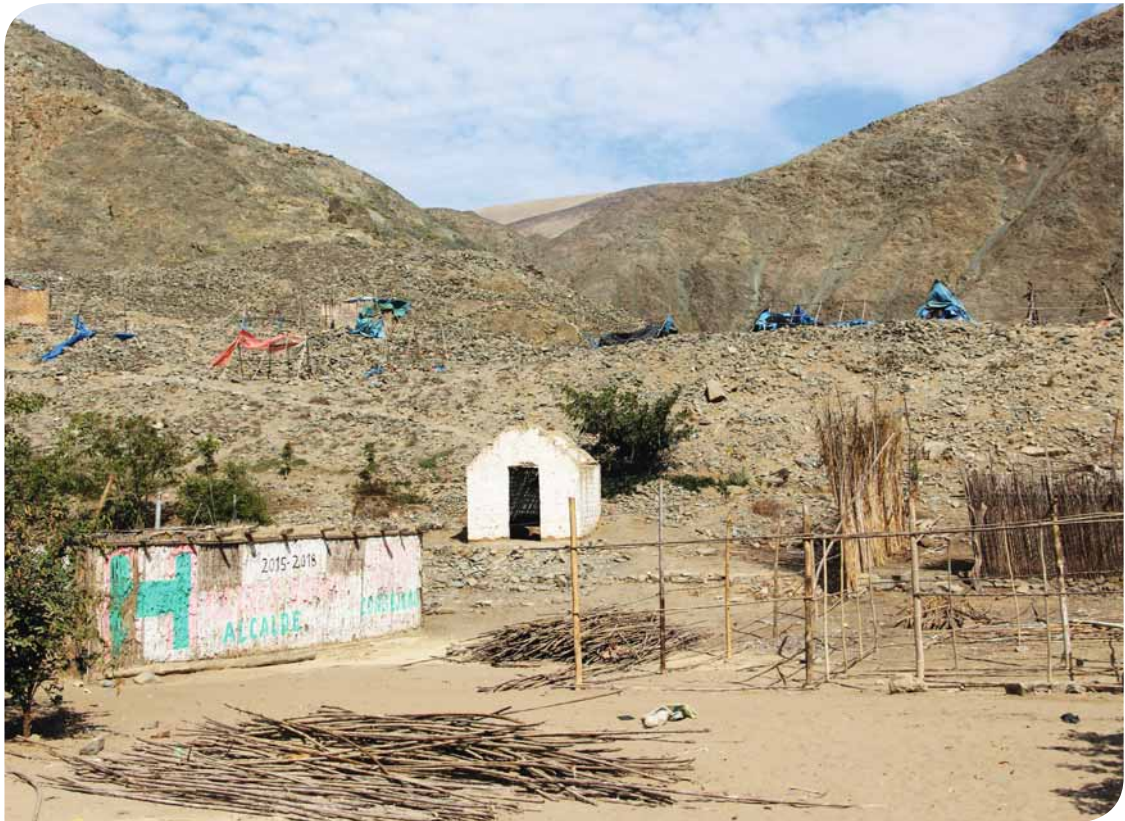
Weggeschwemmte Behausungen im Talboden, oben die Überbleibsel von Notunterkünften bei Nivin, Casma
