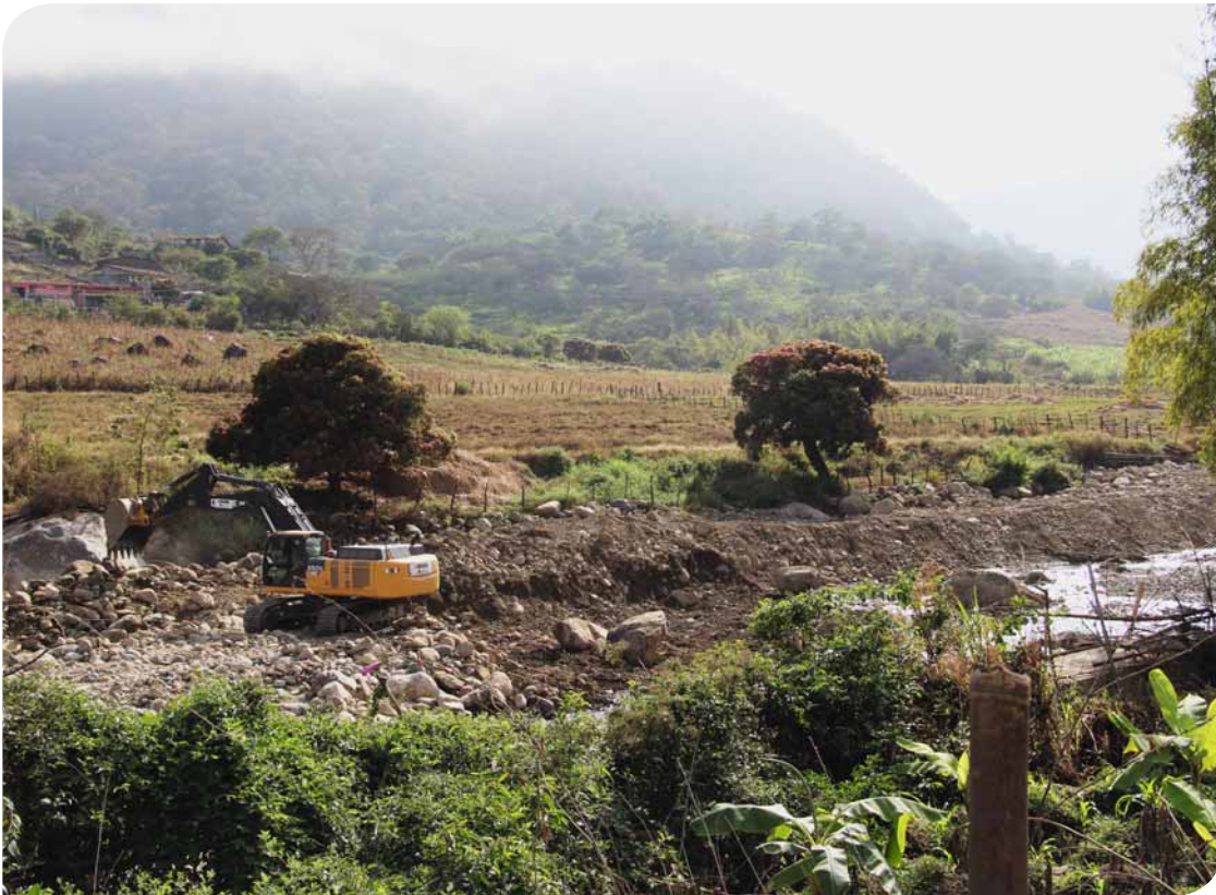
Aufräumarbeiten im Morropon-Fluss
